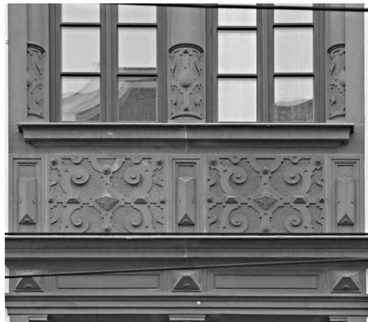
Fenster über dem Eingangsportal
