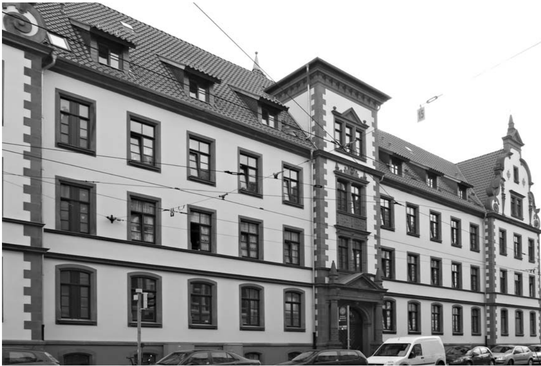
Straßenfassade nach Nordosten
