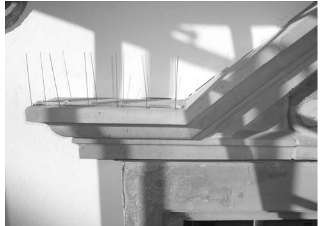
Ersatz durch ein neues Massivstück nach Vorbild der anderen Giebelhälfte
