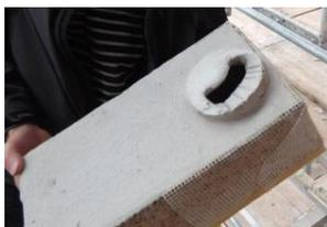
Und für Fledermäuse sind bei der Erneuerung des Daches sogar Nistgelegenheiten eingebaut worden. Auf dem Bild links sieht man einen hohlen Baustein mit Nisthöhle.
